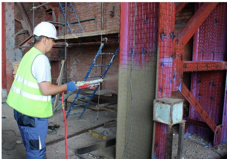
*Материал наносится послойно, расстояние от обрабатываемой поверхности до сопла 15-20 см, сопло необходимо располагать перпендикулярно к поверхности*
